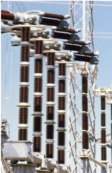
Disjoncteur à air comprimé
